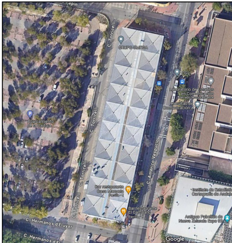
Emplazamiento del edificio N1
