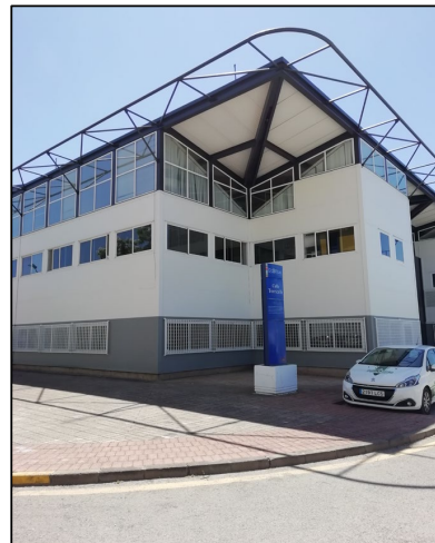
Vista exterior del edificio N1
