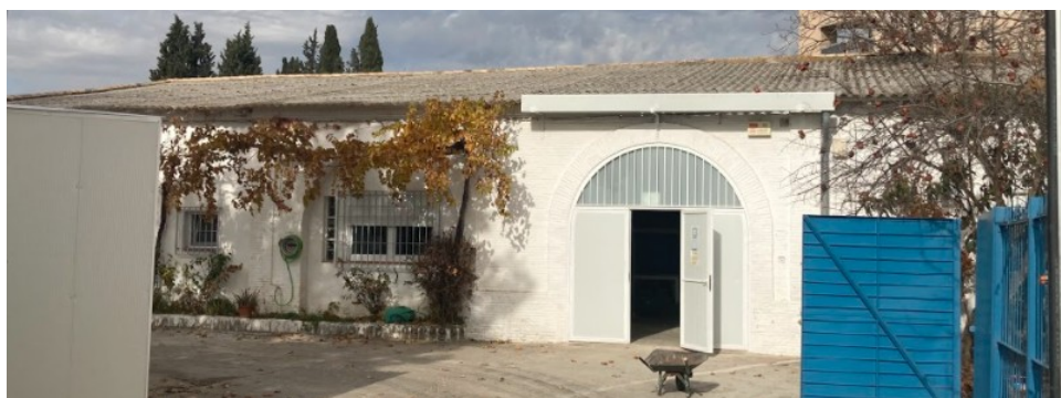
Vista de parte de la cubierta
