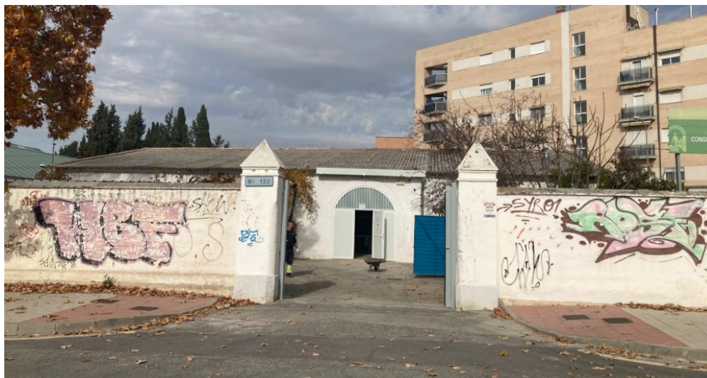
Vista de toda la cubierta
