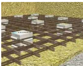
1- Colocación de los contenedores del sistema de baja frecuencia de resonancia, unidos al mallazo de 12 mm. y film protector transparente de polietileno.
