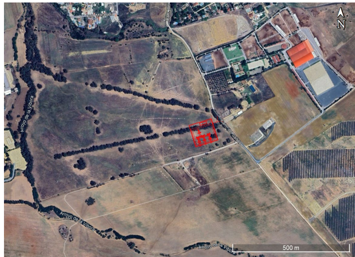
Localización detalle subestación eléctrica. Aplicación Google Earth.
