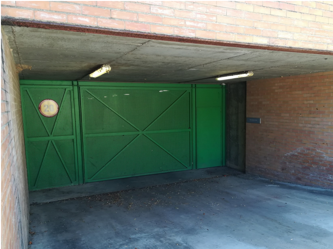
Ilustración 5: Acceso n.º 1: Final de la rampa y puerta exterior del muelle de descarga
