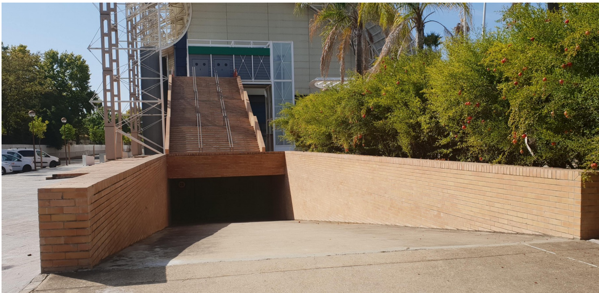
Ilustración 4: Acceso nº 1: Rampa de descenso a Área de Depósitos
