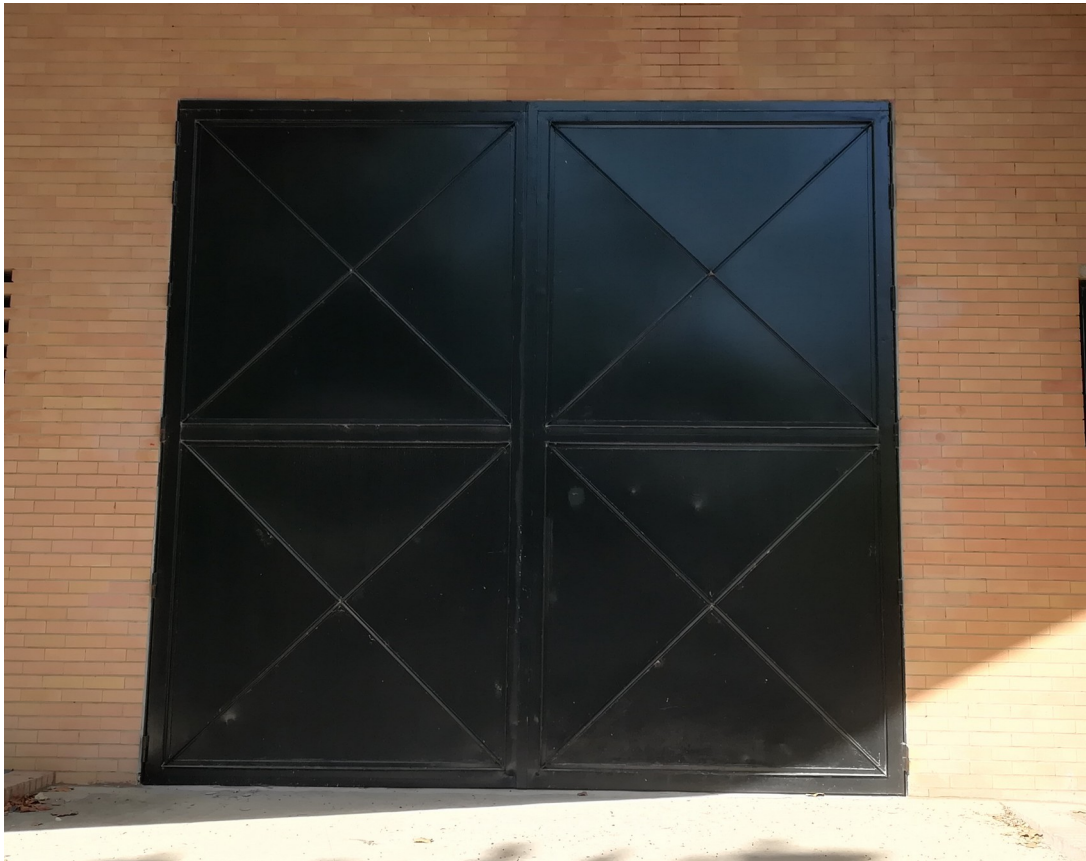
Ilustración 12: Acceso nº 3: Puerta exterior
