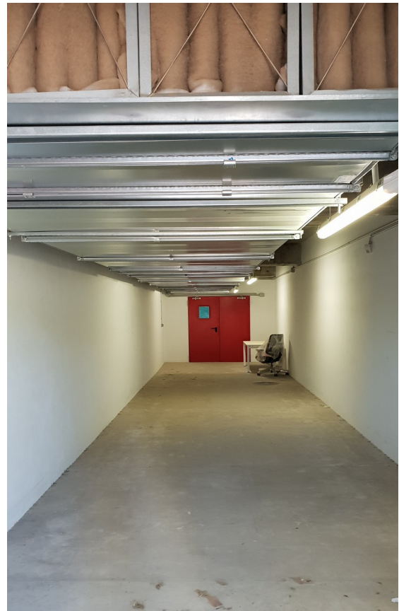
Ilustración 9: Acceso nº 2: Muelle de descarga
