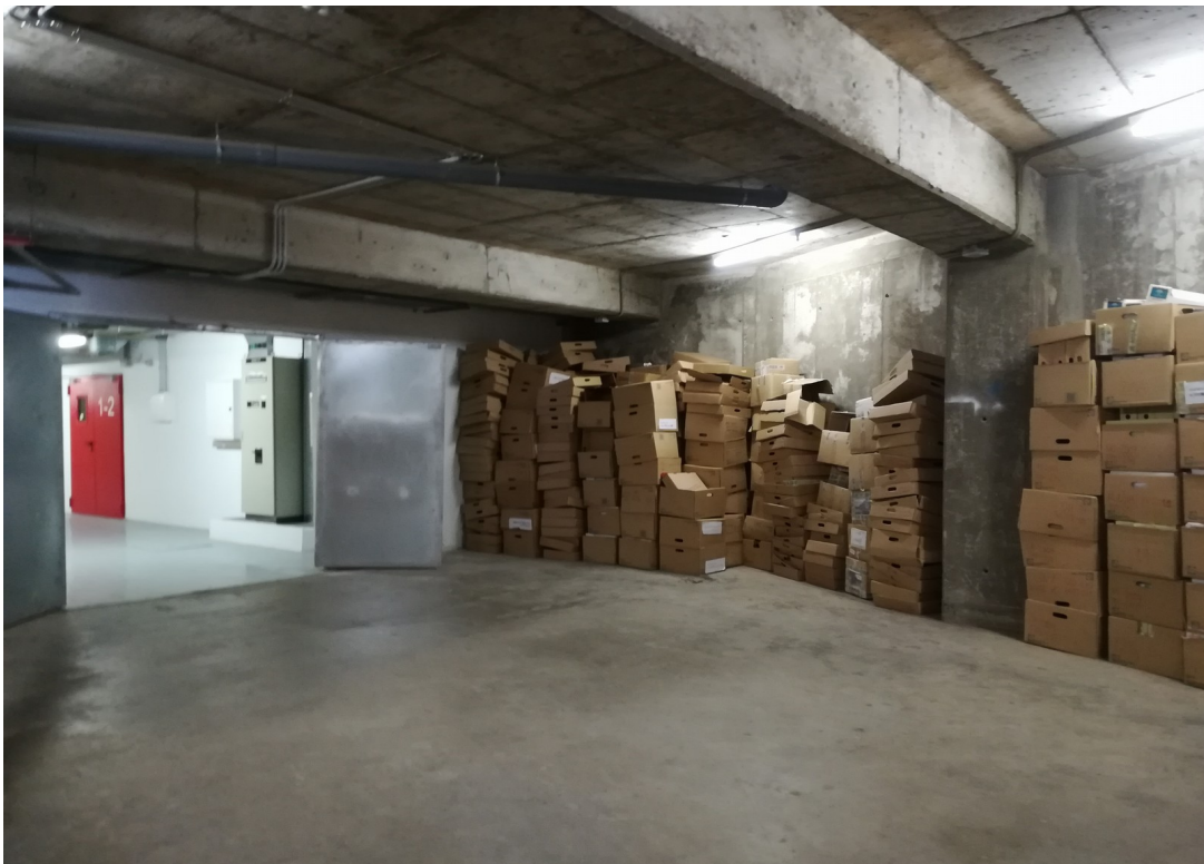
Ilustración 6: Acceso n.º 1: Muelle de descarga
