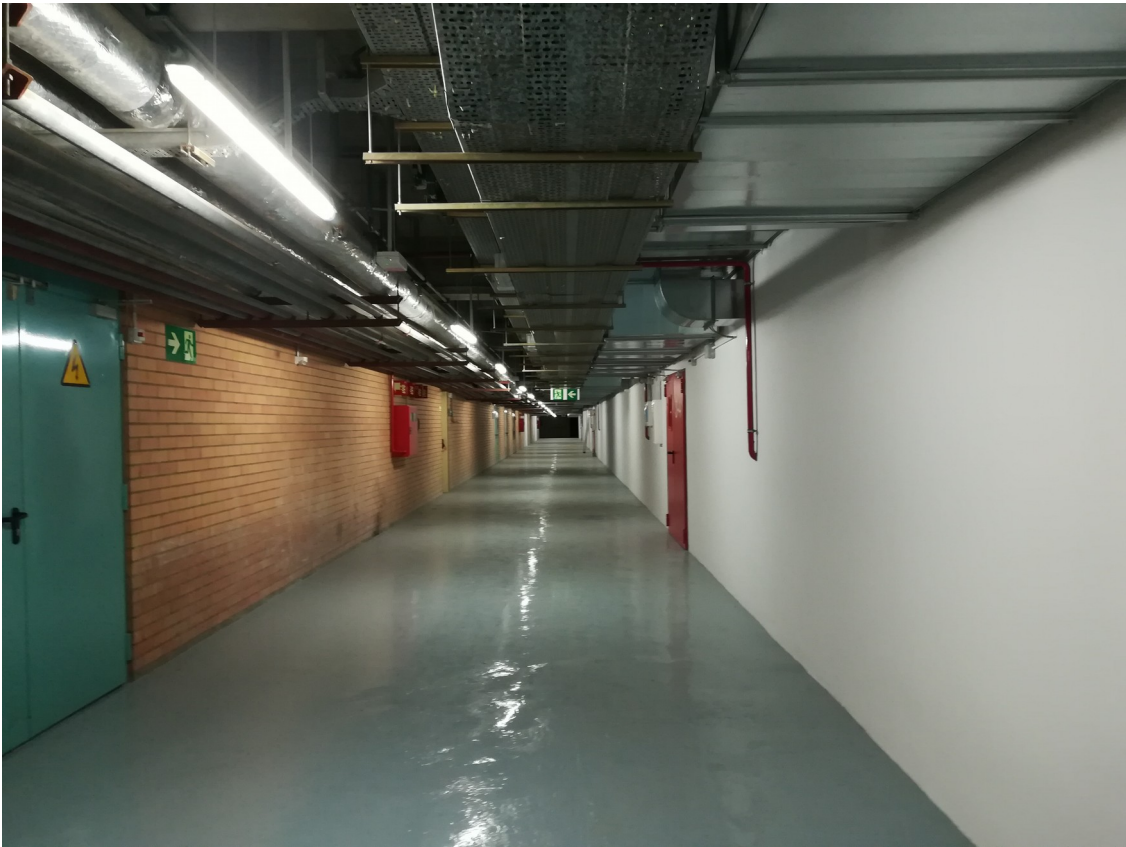
Ilustración 14: Pasillo del Área de Depósitos D-1 a D-16
