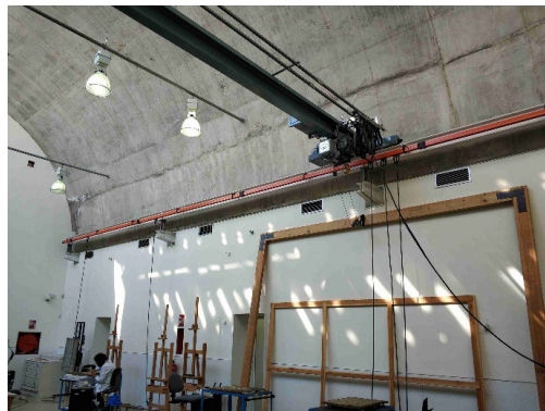
Fig. 4.4.C. Rejillas de impulsión y retorno en el taller de pintura
