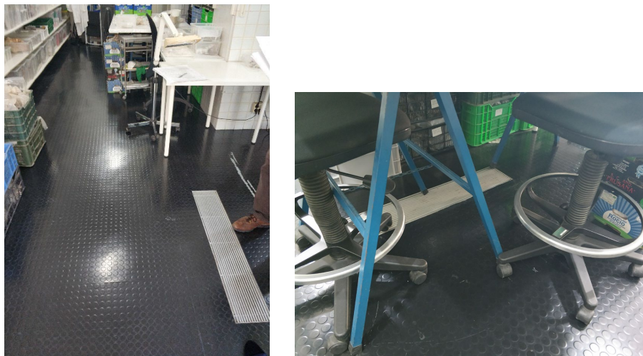
Fig. 11.3.A. Difusión de aire por suelo en el Taller de Paleobiología (planta baja)
