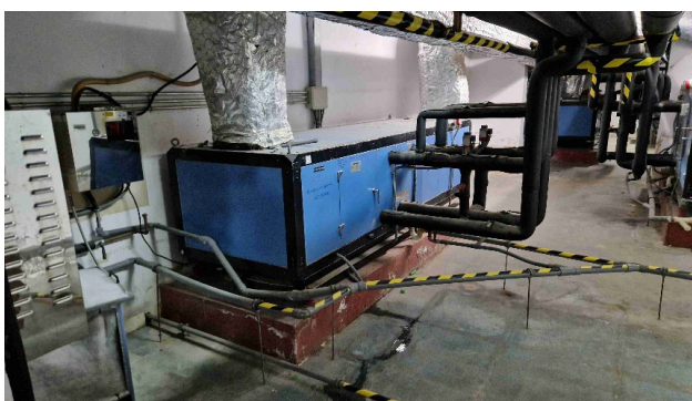
Fig. 4.1.B. Climatizador CLI-15 (Almacén Bienes Culturales) con humidificador
