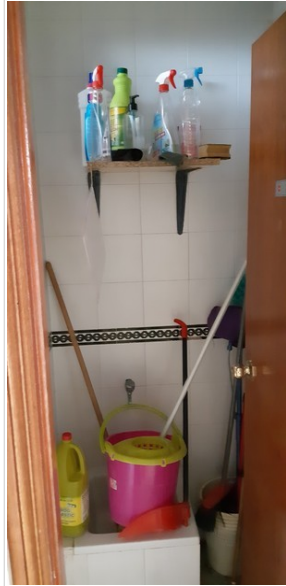
Fotografía n.º 41. Pila de azulejo y grifo
