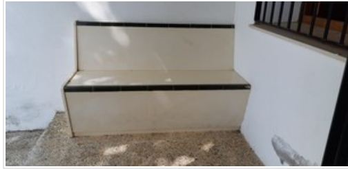
Fotografía n.º 79. Banco de obra
