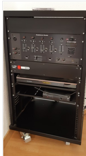
Fotografía n.º 47. Mesa negra de mezclas
