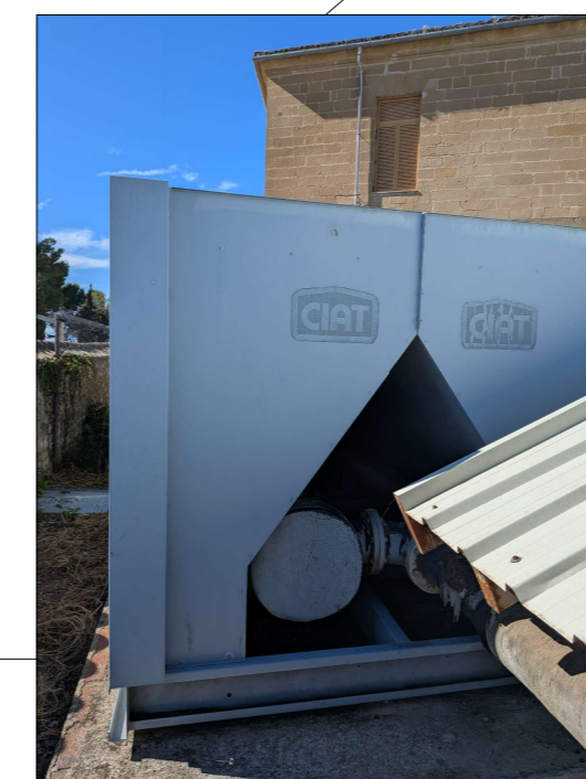
Climatizadora marca CIAT tipo Root-Top con producción de calor por combustión.
