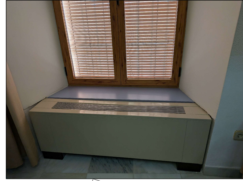
Detalle fancoils existentes en el edificio
