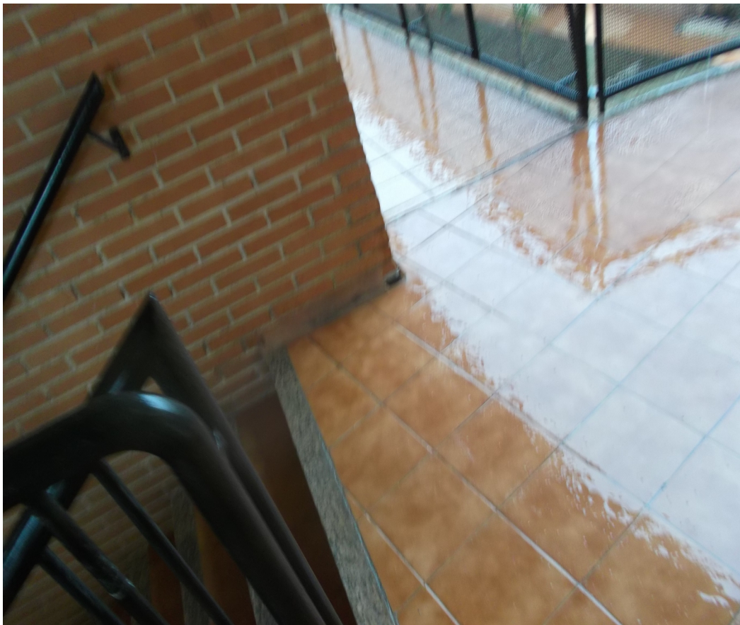
Zona común de deslizamientos de subida a galerías en planta 2ª.
