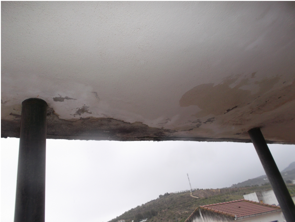
Zona de cubierta en esquina deteriorada por las humedades.
