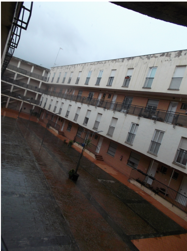
Zona de Patio común interior
