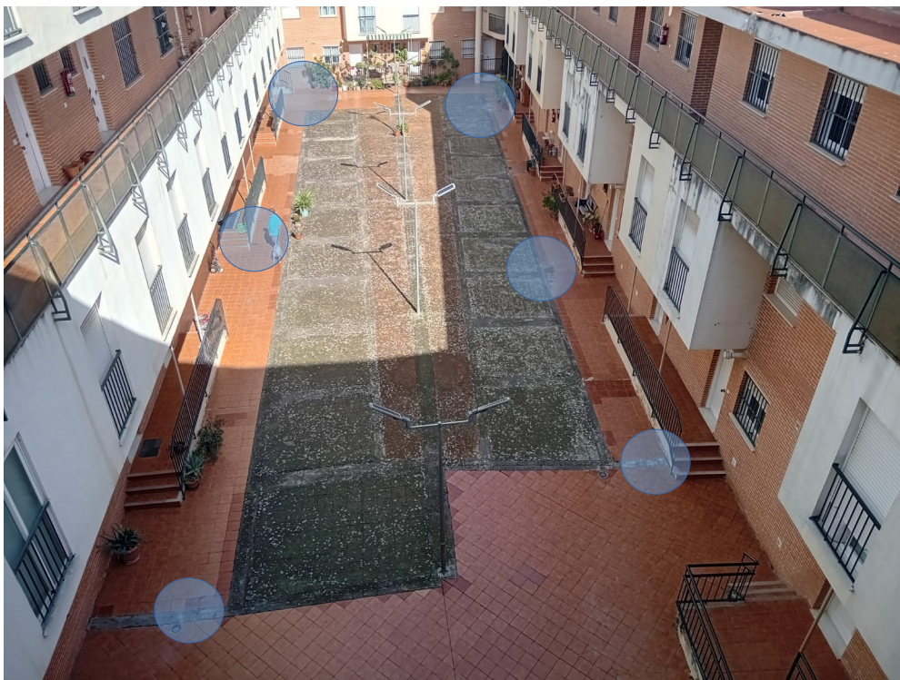
Zona Común en patio central donde se localizan los sumideros que provocan humedades en garajes
