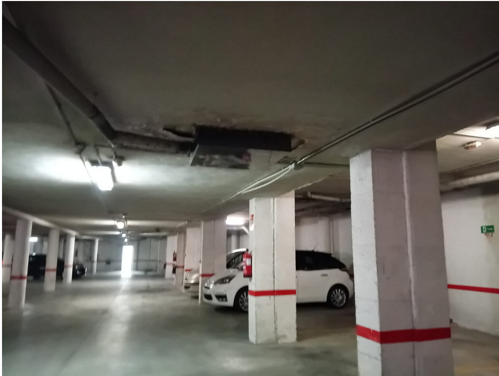
Zona Común en patio central donde se localizan los sumideros que provocan humedades en garajes
