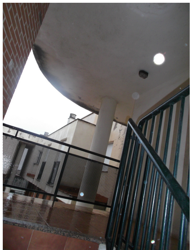
Zona común de subida a terrazas en planta 3ª
