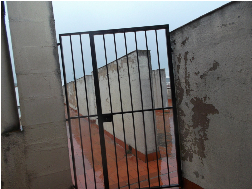
Zona de cubierta en esquina deteriorada por las humedades.
