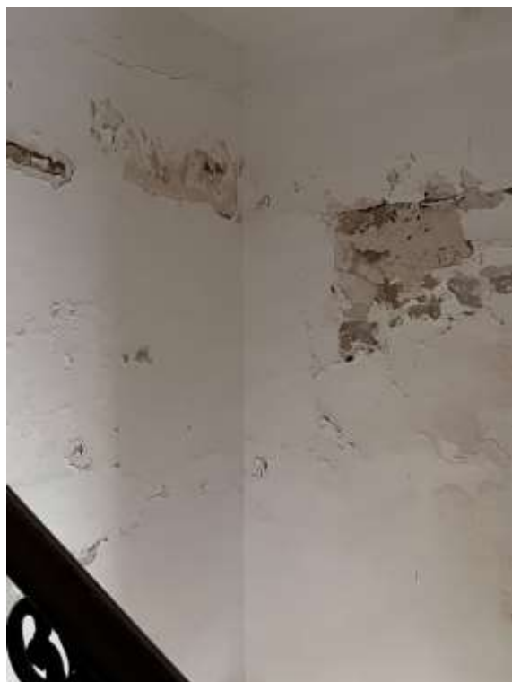
Filtración de agua en castillete de Casa Norte y evidencia de falta de estanqueidad en el exterior del castillete de Casa Sur.
