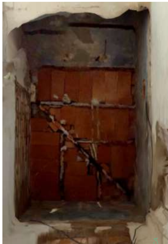
Filtración de agua en el forjado de planta 2ª en Casa Norte, así como humedades en los cerramientos. Oxidación de viguetas en planta 2ª de Casa Sur.
