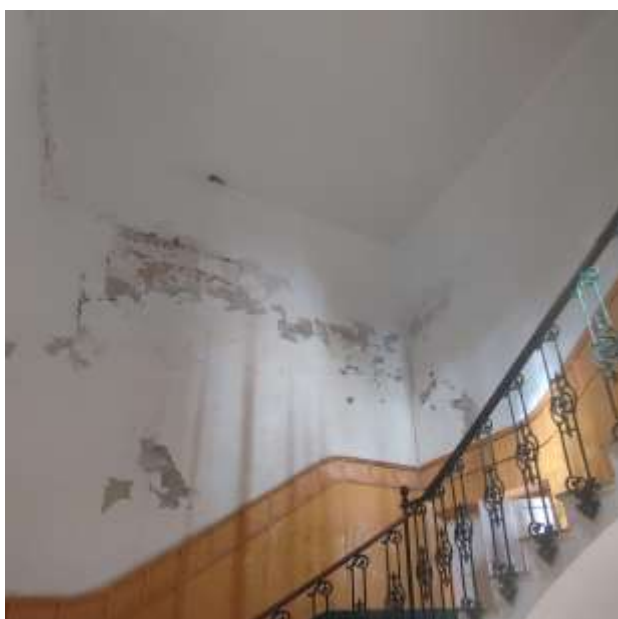
Forjado de castillete de Casa Norte
