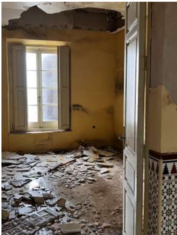
Filtración de agua en el forjado de planta 2ª en Casa Norte, así como humedades en los cerramientos. Oxidación de viguetas en planta 2ª de Casa Sur.
