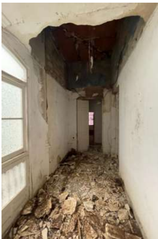
Desprendimientos de falsos techos en forjado de cubierta y estado de las viguetas. Casa Sur
