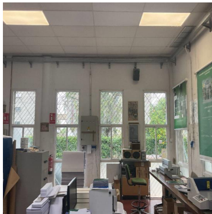
Ilustración 32 Luminaria Planta 0 oficinas
