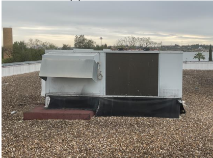
Ilustración 11 Equipo aire aire Climaveneta RMN 0202
