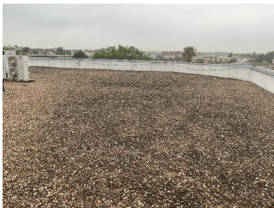
Ilustración 5 Visualización cubierta del edificio
