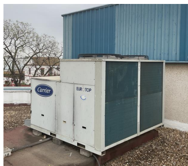
Ilustración 15 Equipos aire-aire Carrier
