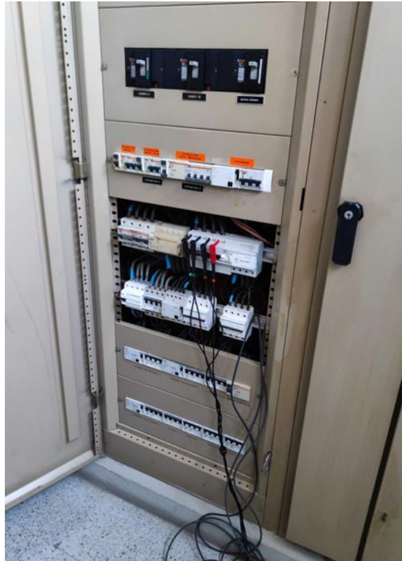
Ilustración 49 Instalación del analizador de redes
