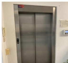
Ilustración 35 Ascensor Planta 0 Pasillo
