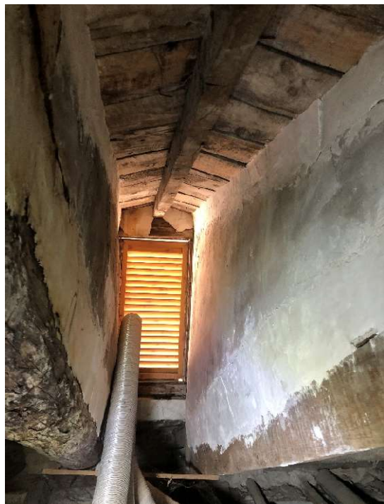
IMAGEN 8. Vista interior mansarda de ventilación.
