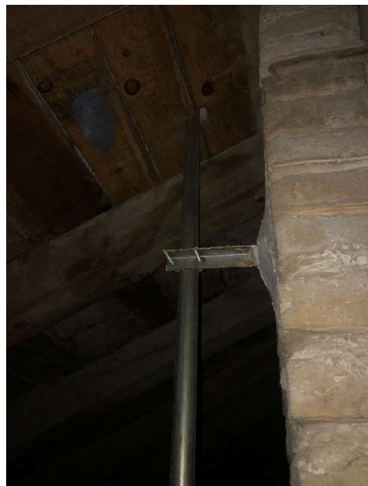
IMAGEN 16. Soporte antenna. Encuentro con tablazón.
