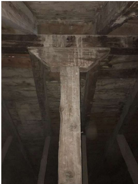
IMAGEN 3. Pie derecho con zapata y picadero.
