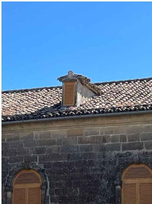
IMAGEN 31. Canalón, cornisa y cubierta ala oeste. Detalle de hilada de ladrillo “¿paranieves?”
