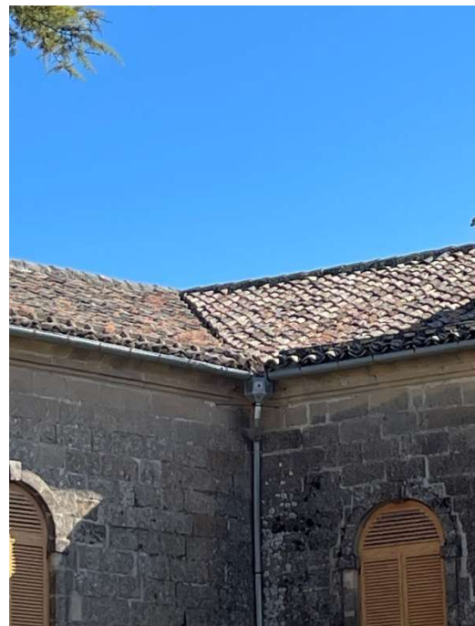
IMAGEN 31. Canalón, cornisa y cubierta ala oeste. Detalle de hilada de ladrillo “¿paranieves?”
