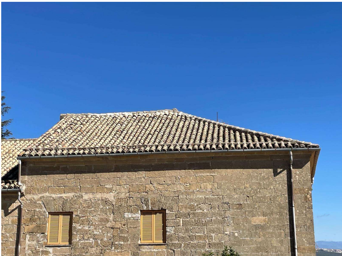
IMAGEN 30. Vista exterior cubierta ala sur con oeste.
