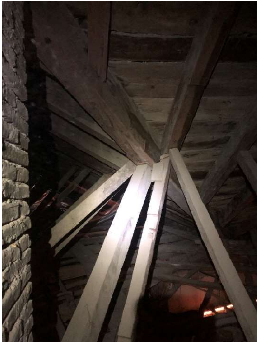
IMAGEN 13. Refuerzos de tornapuntas.
