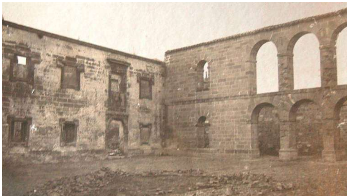
Vista del edificio en 1923. Patio central. Ventanas tapiadas del ala oeste y sin cubierta.
