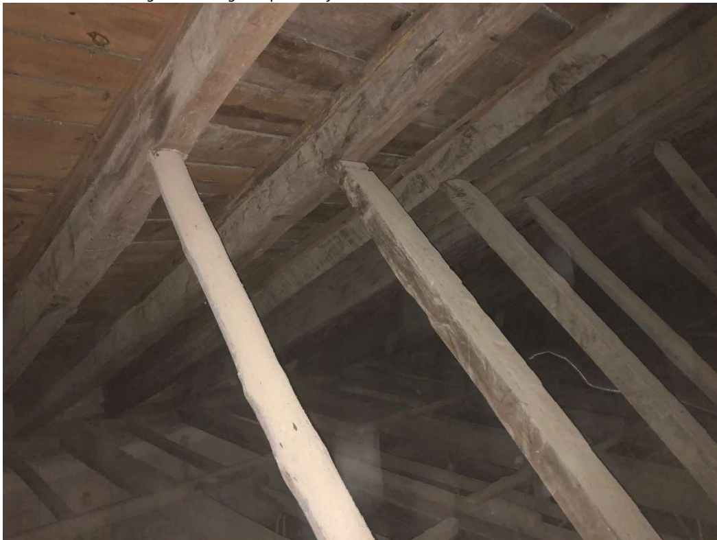
IMAGEN 24. Zona irregular de antiguo soporte de falso techo.
