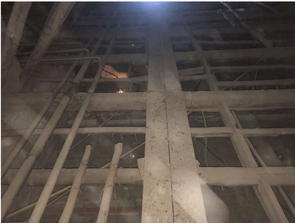
IMAGEN 26. Encuentro estructura falso techo con pares en durmiente de muro. Ala Sur.
