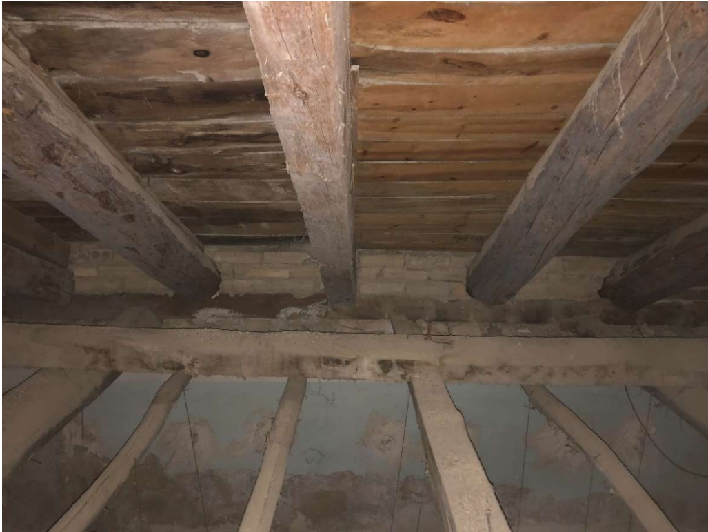
IMAGEN 26. Encuentro estructura falso techo con pares en durmiente de muro. Ala Sur.
