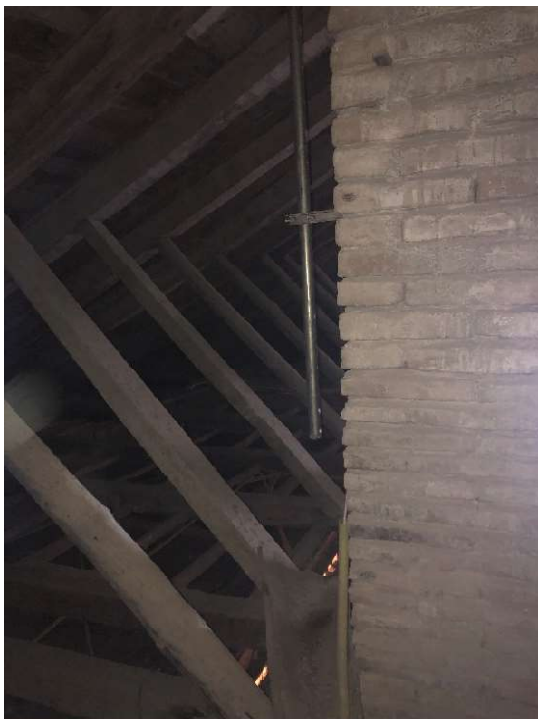
IMAGEN 15. Soporte antenna. Desagüe provisional con teja.
