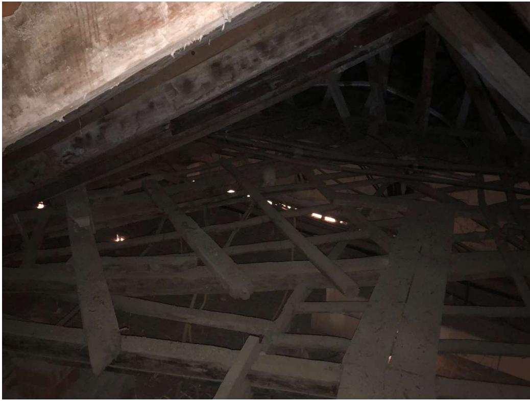
IMAGEN 24. Zona irregular de antiguo soporte de falso techo.
