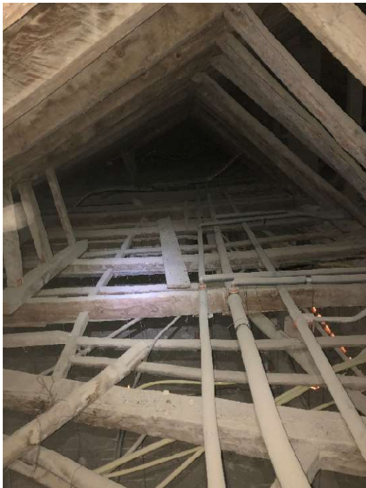
IMAGEN 11. Vista interior estructura falso techo.
