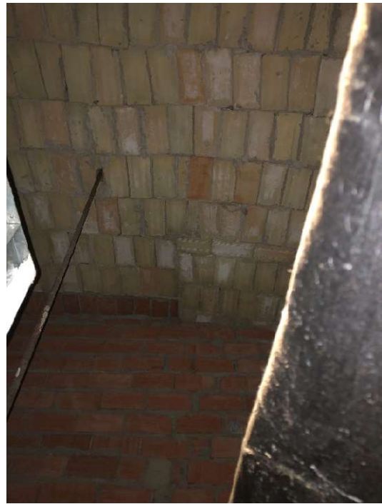
IMAGEN 22. Bóveda ladrillo ala oeste.
