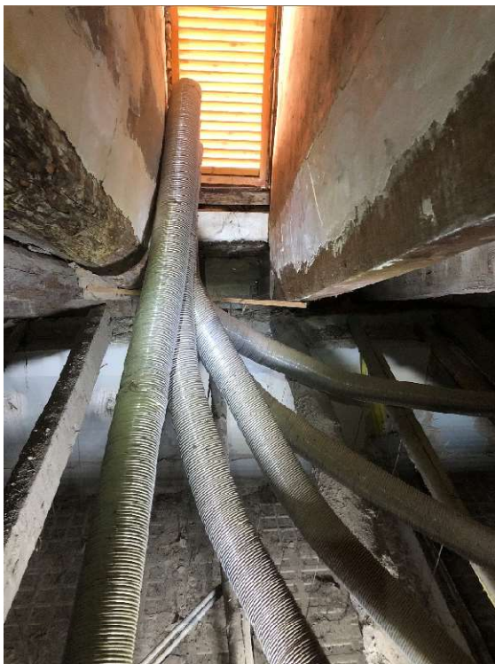
Estado actual de instalaciones de ventilación y electricidad bajo cubierta.
