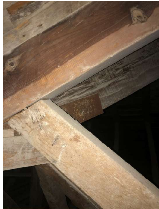
IMAGEN 10. Refuerzo limatesa Sur-Este.
