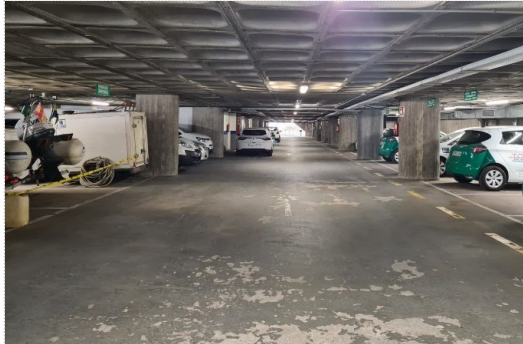
Vista general del Sótano -1
