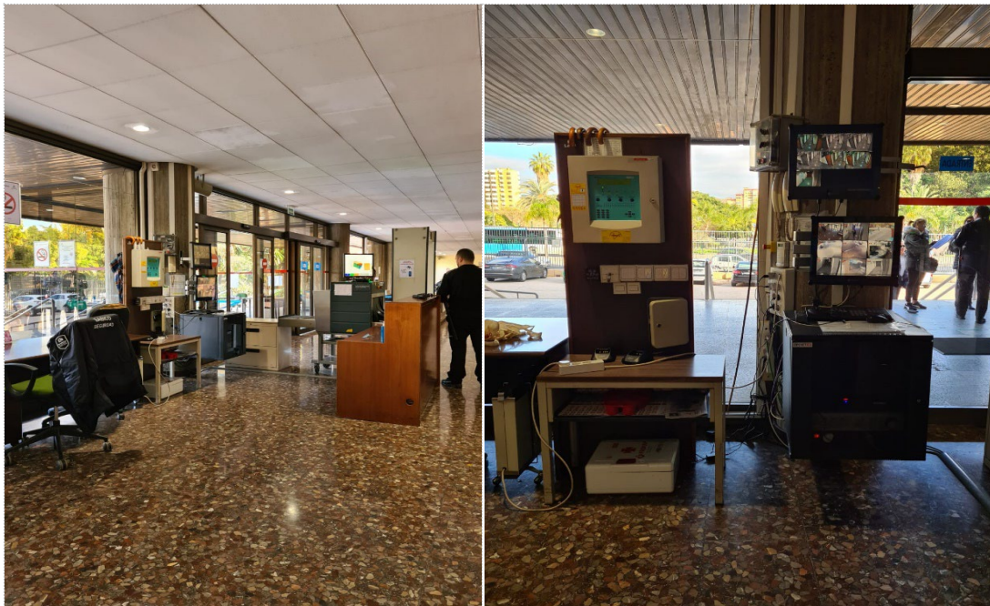
Control de acceso en vestíbulo / Centralitas y cámara de video vigilancia
