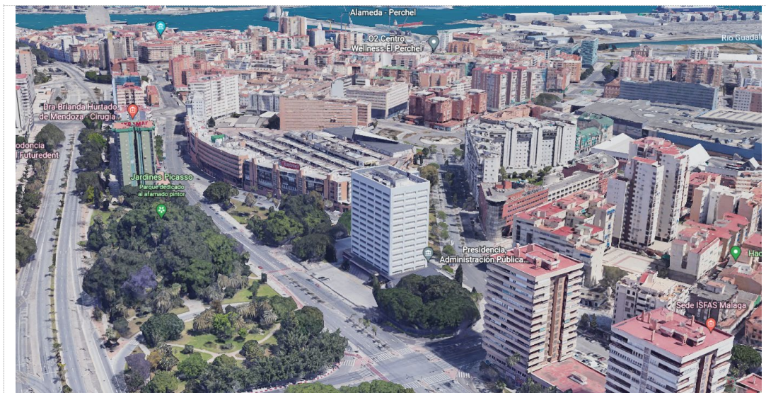
Vista general del Edificio en su entorno urbano
