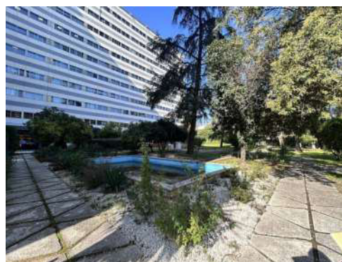
Foto 20.- VISTA FACHADA OESTE, DESDE EL PATIO INTERIOR
