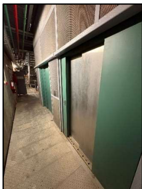
Fotografía. Vista exterior Montacargas
