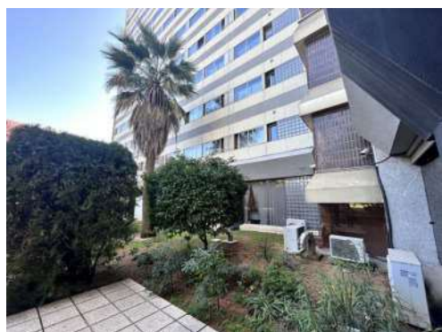
Foto 19.- VISTA FACHADA DEL ALA SUR, DESDE EL PATIO INTERIOR
