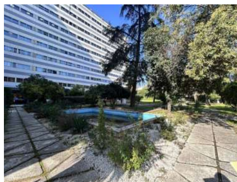
Foto 20.- VISTA FACHADA OESTE, DESDE EL PATIO INTERIOR
