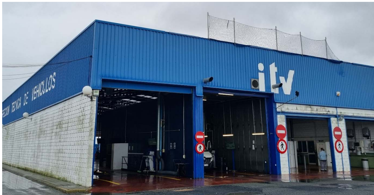
Puertas de salida de las líneas de inspección L1 y L2
