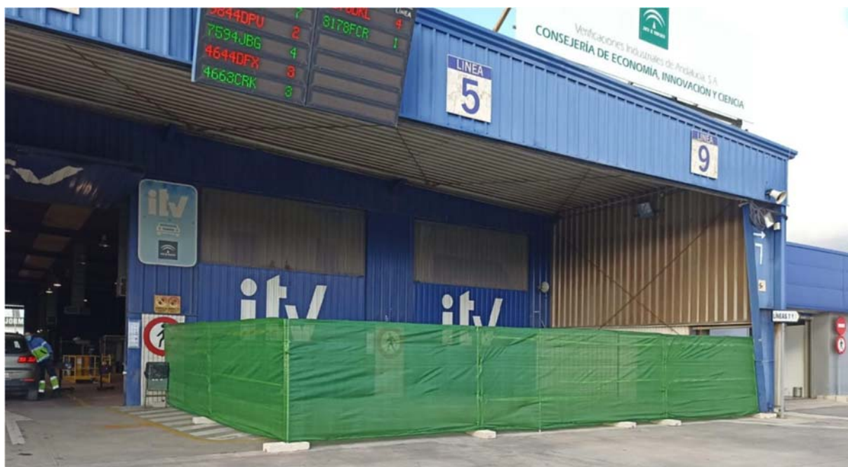
Ejemplos de delimitación de la zona de actuación durante la ejecución de las obras
