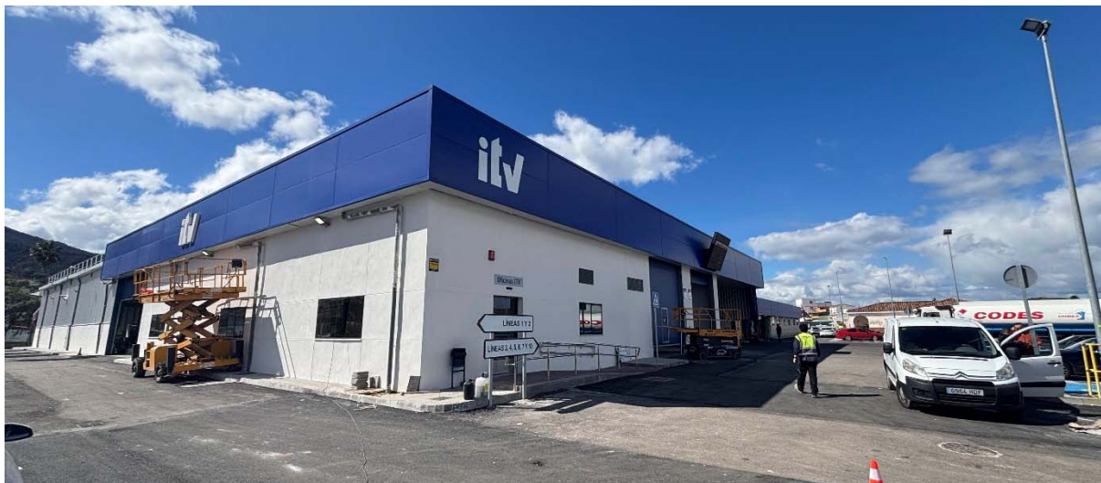
Rótulos luminosos instalados en los petos de oficinas y nave
