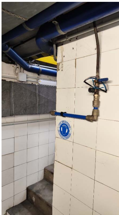
Instalación de aire comprimido en los fosos de inspección
