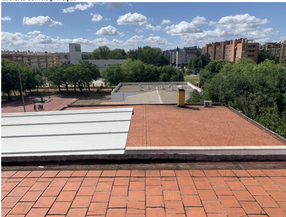
Cubierta edificio ampliación
