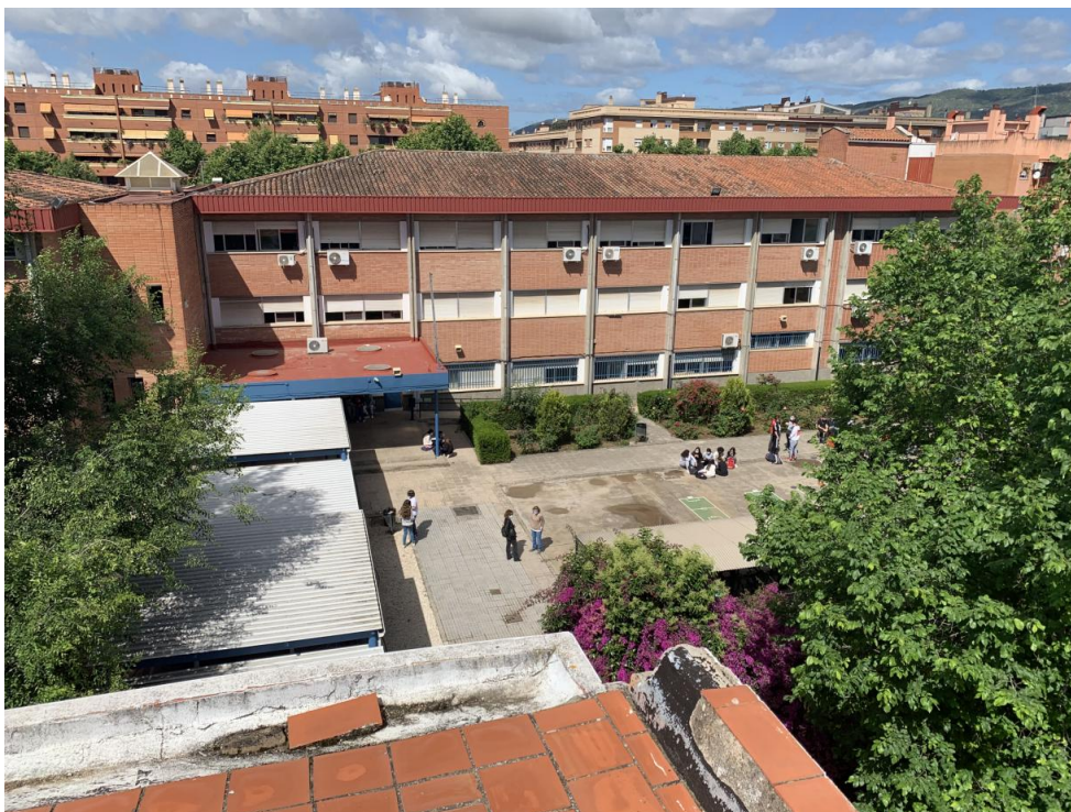
Cubierta edificio principal
