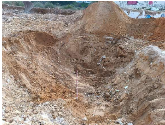
Excavación para extracción de zapata central 1.
