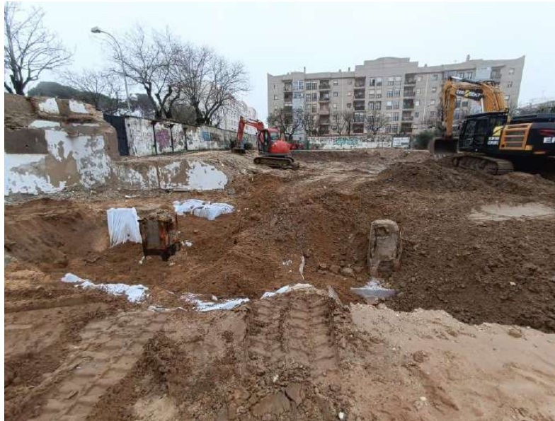
Cubrición final en torno a la zapata de cimentación 4 y 5.
