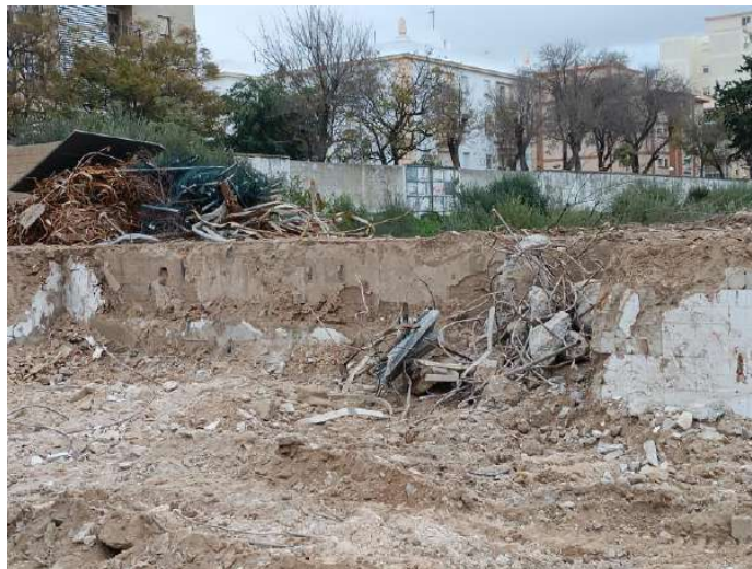
Muro de zapata perimetral 3.
