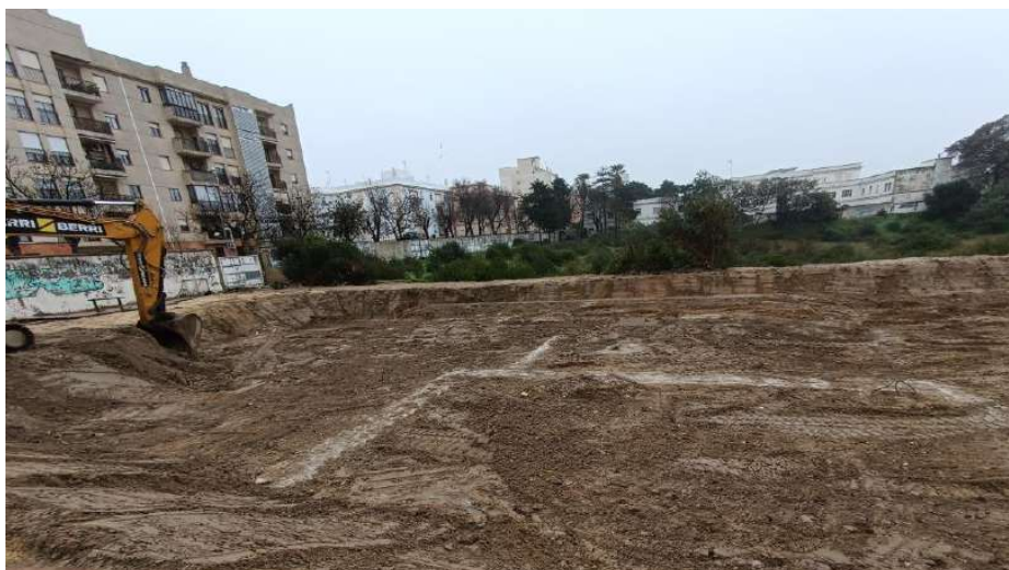
Vista desde oeste del solar con correas de cimentación.
