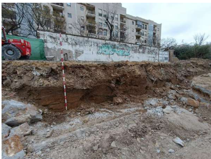
Muro de zapata perimetral 5 extraído.
