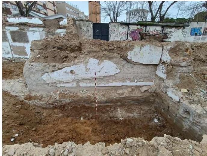
Zapata perimetral 2. Tramo extraído hasta zapata.
