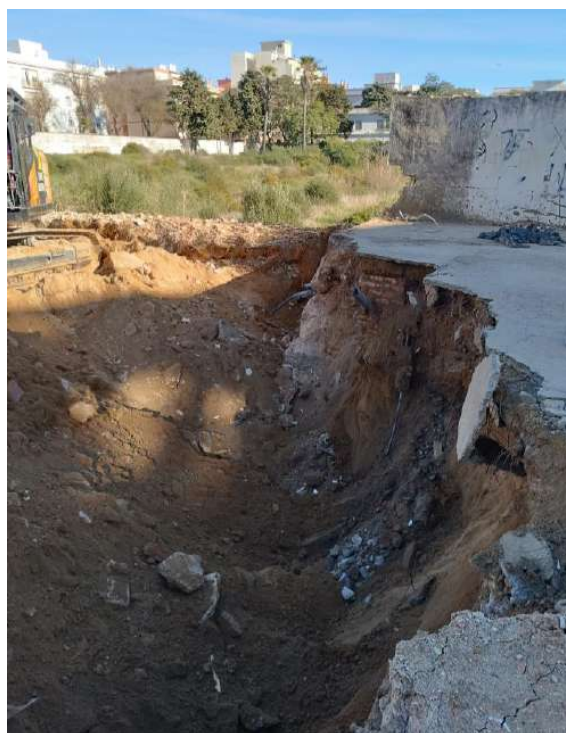
Muro y zapata perimetral 1.
