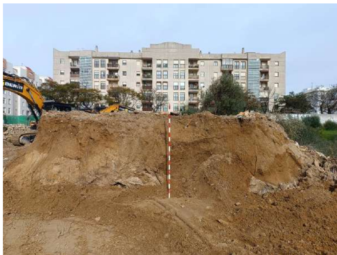
Talud de tierra entre zapata perimetral 3 y 4.
