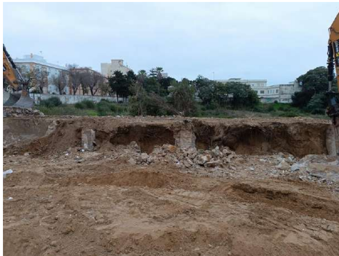
Muro de zapata perimetral 3 extraído.
