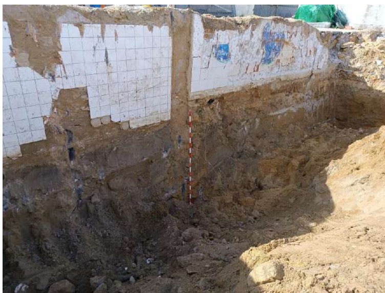
Muro y zapata perimetral 1.
