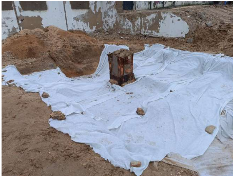
Cubrición con geotextil en torno a la zapata de cimentación 4.
