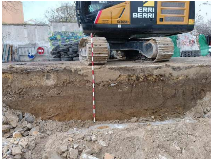
Zapata perimetral 2. Extracción de muro.
