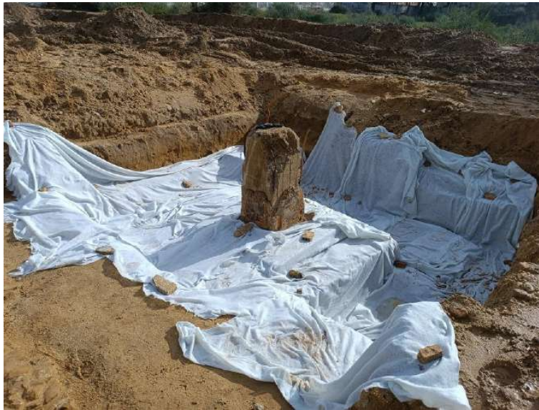
Cubrición con geotextil en torno a la zapata de cimentación 5.
