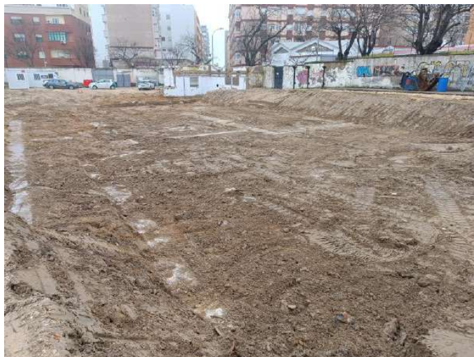
Vista desde noreste del solar con correas de cimentación.
