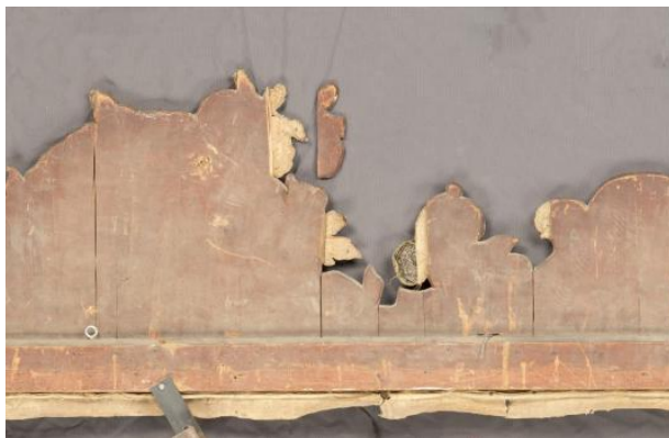
Roturas y pérdidas de soporte
