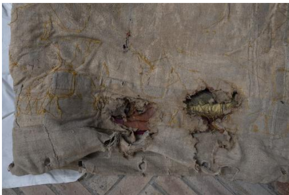
Deformaciones por dilatación
