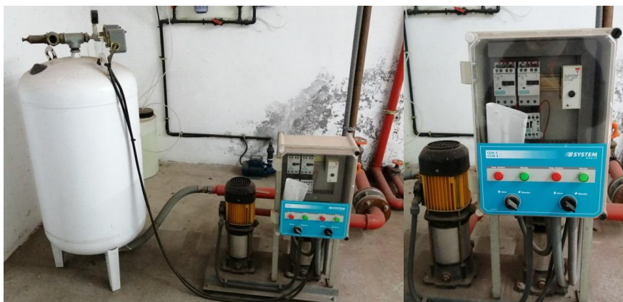
Grupo de presión de agua para módulo 1 (laboratorios)
