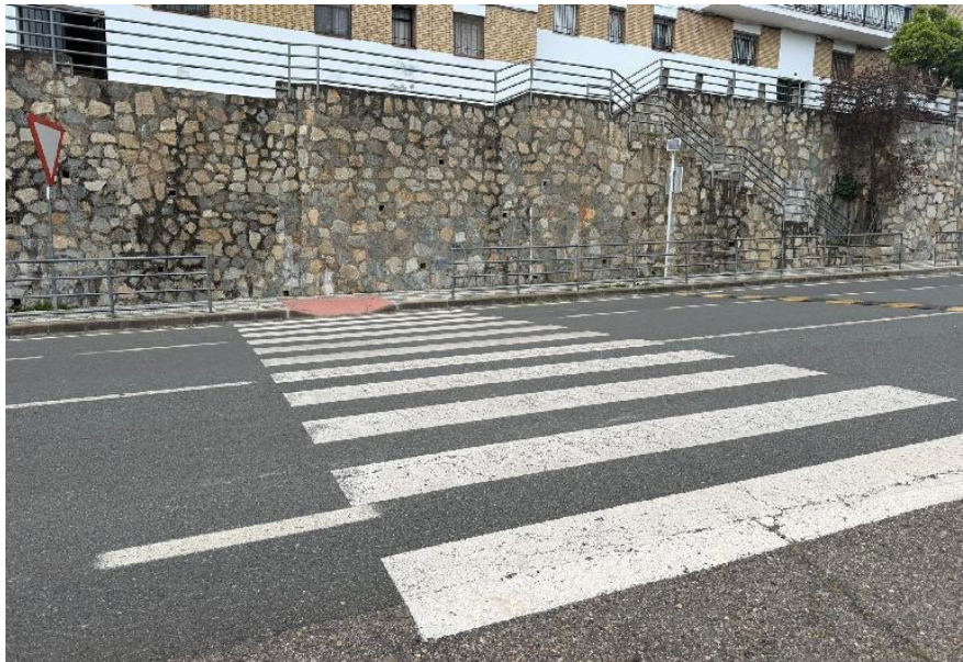
A-455 PPKK 19+000-21+500 ESTADO PASOS PEATONES (9)
