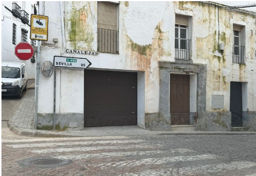
A-455 PPKK 19+000-21+500 ESTADO PASOS PEATONES (1)
