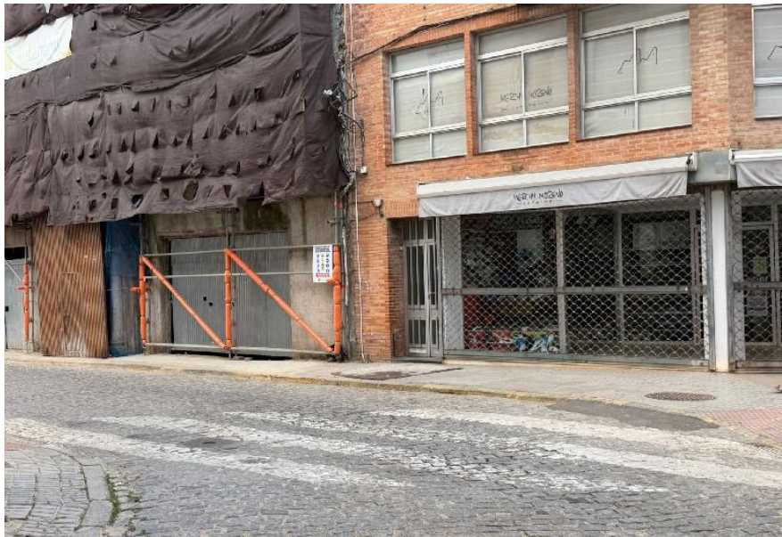
A-455 PPKK 19+000-21+500 ESTADO PASOS PEATONES (2)
