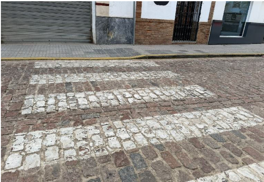
A-455 PPKK 19+000-21+500 ESTADO PASOS PEATONES (5)
