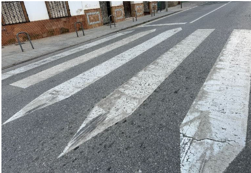
A-455 PPKK 19+000-21+500 ESTADO PASOS PEATONES (7)
