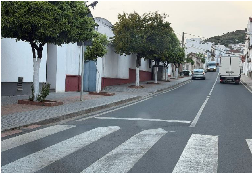
A-455 PPKK 19+000-21+500 ESTADO PASOS PEATONES (8)
