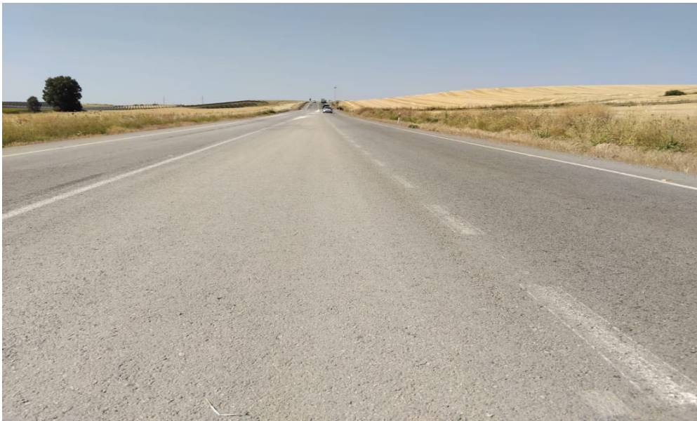
A-457 PPKK 0+000-25+110 SEÑALIZACIÓN H (1)
