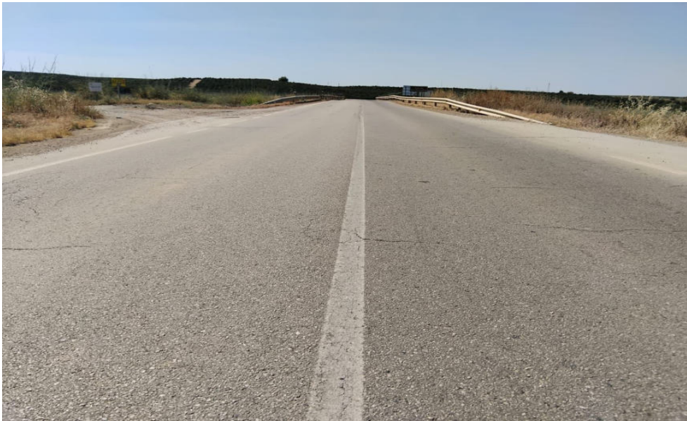
A-457 PPKK 0+000-25+110 SEÑALIZACIÓN H (3)
