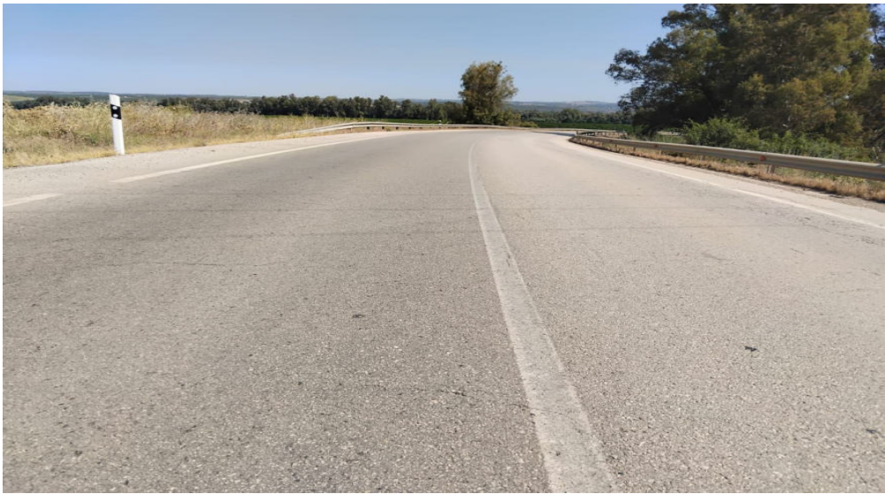
A-457 PPKK 0+000-25+110 SEÑALIZACIÓN H (2)
