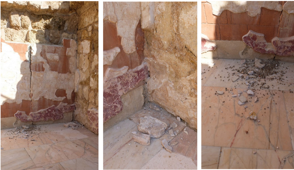
Fig. 2 a 4. Daños en extremo oriental: desprendimientos de puntos de agarre y de revestimiento
