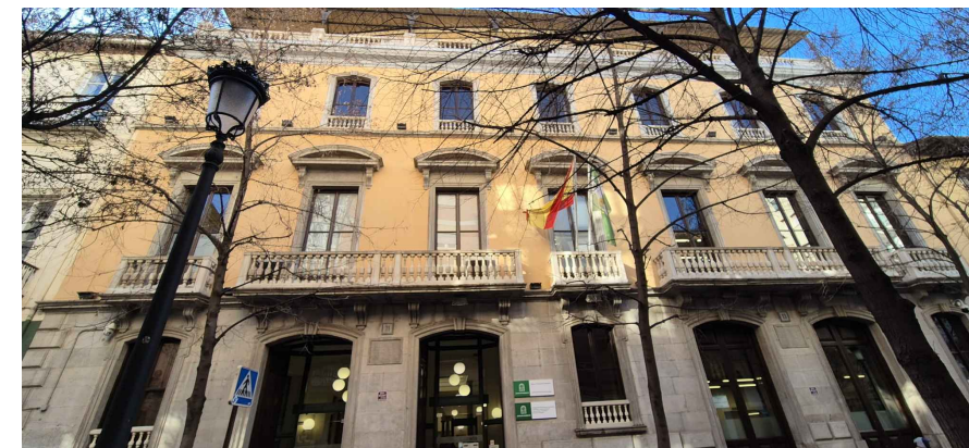
FOTO DE FACHADA
