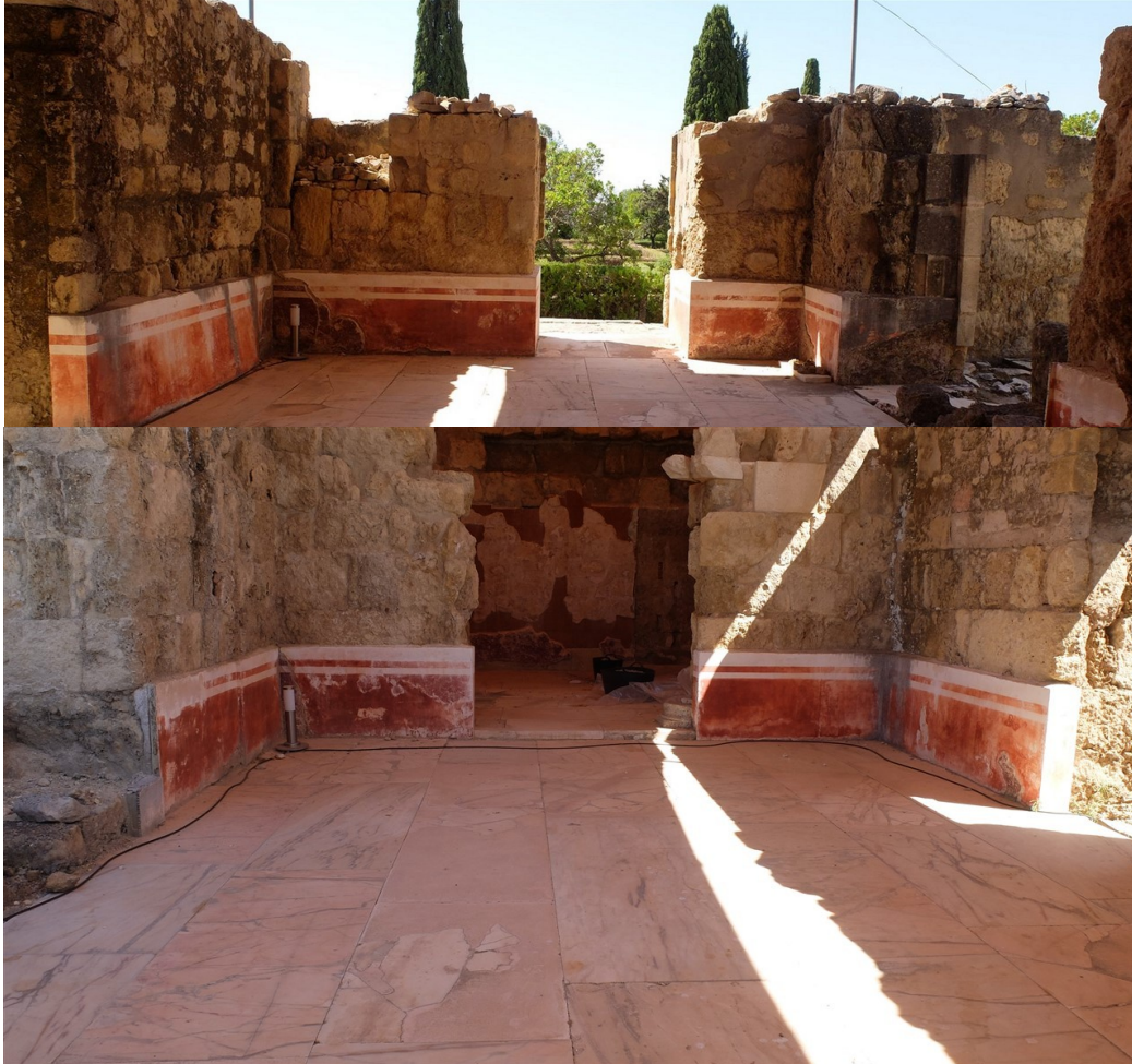
Fig. 8 a 10. Jamba entre espacios 7 y 8. Vistas generales (sup.) y detalle (inf.)
