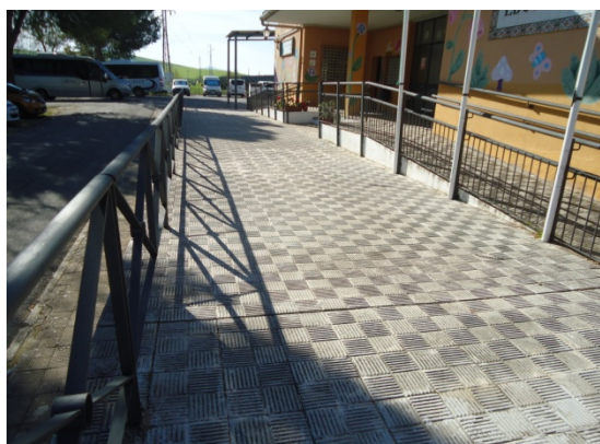
FOTO N° 18: Filtraciones vuelo exterior
