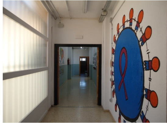
FOTO Nº 50: Filtraciones junta de dilatación
