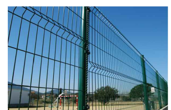
VALLADO PERIMETRAL TIPO BEKAERT A 2m DE LOS CONTENEDORES
