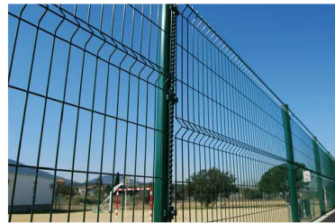
VALLADO PERIMETRAL TIPO BEKAERT A 2m DE LOS CONTENEDORES
