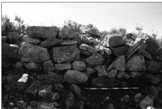
Figura 5. Alzado del paramento exterior de la muralla, al noreste.
