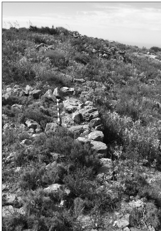
Figura 7. Paño de la muralla noroeste; al fondo la torre 2.
