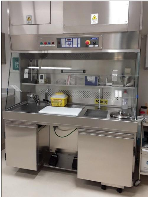
**Cabina extractora** con sistema de extracción independiente hacia el exterior:
