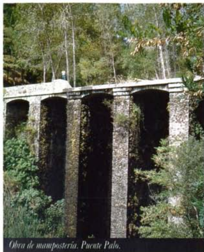
Obra de mampostería. Puente Palo.
