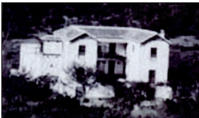
Estado actual de la construcción
