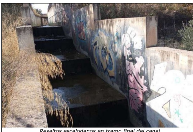
Resaltos escalonados en tramo final del canal
