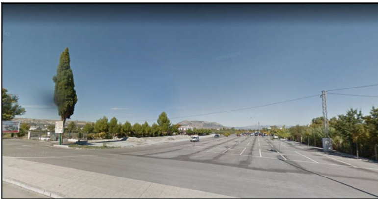
Tendidos eléctricos tras atravesar el SUS-T-06 en dirección al hospital.
