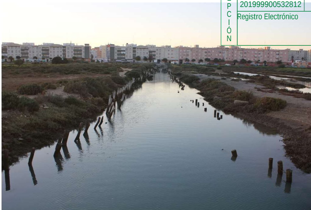
Foto 8. Canal de aguas usado como aliviadero. Fotografía realizada el 9-1-19.
