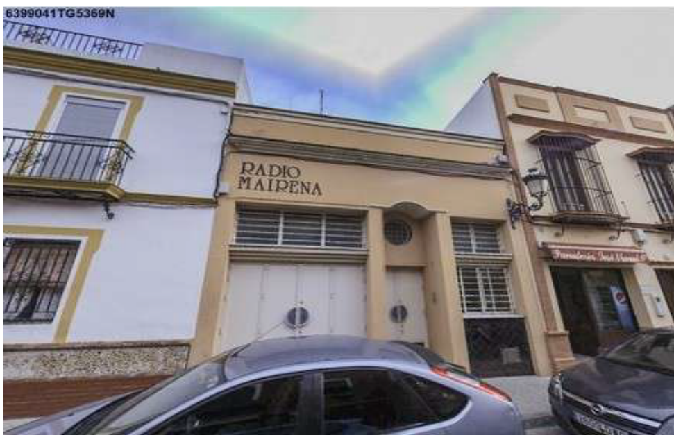
Figura n.º 4. Vista de la fachada del inmueble afectado por la MP-35 (Sede Virtual del Catastro, 2020).
