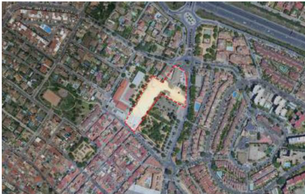
Vista aérea Sector A.O.-4 de Tomares
