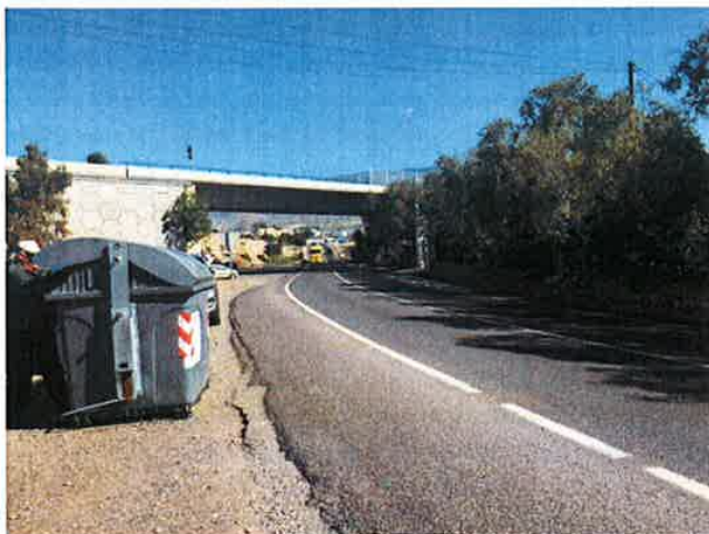
Fotografía 2. Vista de la estructura.
