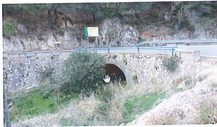
Fig.27. Obra de drenaje existente bajo la curva de la carretera.
