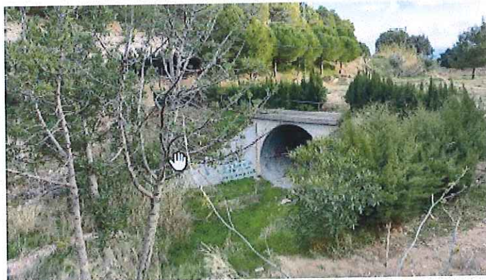
Fig.19. Comienzo del embovedado existente del arroyo de las presas.
