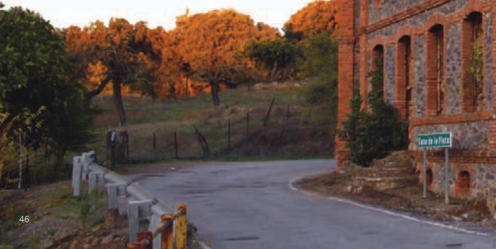
Edificio en ruinas del complejo minero de La Plata 13
