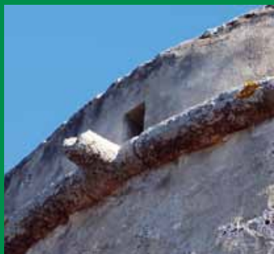
Detalle de la Torre del Tajo
