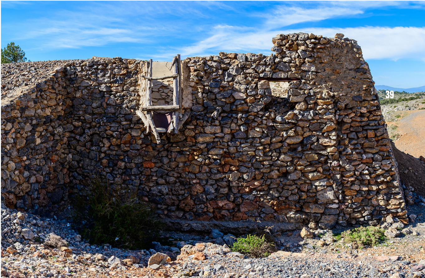
Antiguo cargadero de las Minas del Carmen. Vista frontal de las dos troneras de la tolva.
