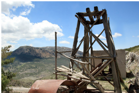
Complejo Minas de la Cruz. Antiguo castillete desplomado en el año 2015 junto con la caseta de máquinas. Foto primer plano: Proyecto Sierra de Baza.
