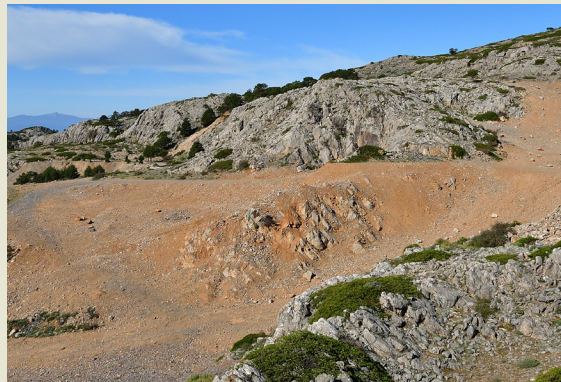
Minas del Carmen y escombreras de la explotación antes y después de la actuación.
