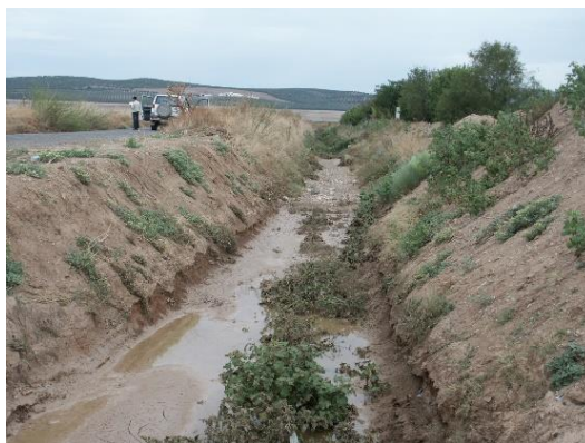
Fotografía del Canal de la Laguna Herrera.
