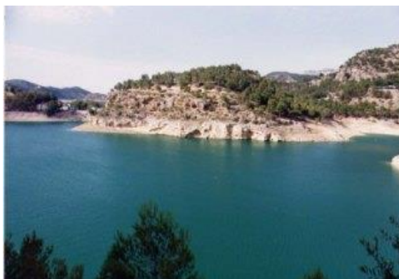
Fotografía del embalse Conde de Guadalhorce.
