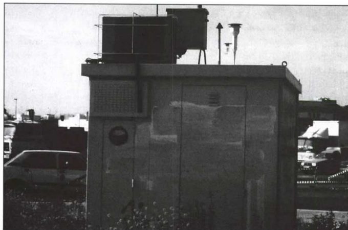
CADA CABINA MIDE LA PRESENCIA EN EL AIRE DE LOS PRINCIPALES CONTAMINANTES.
