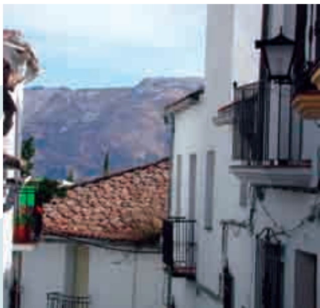
Cerramientos de forja típicos Grilles en fer forgé typiques
