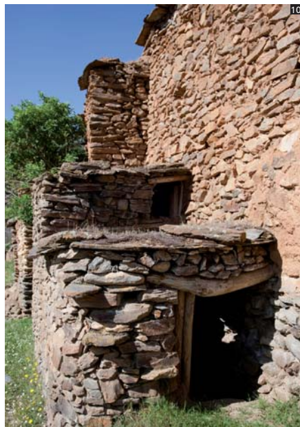
Detalle de las construcciones 10
