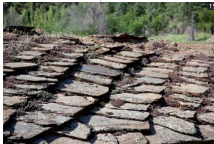
Cubierta de pizarra en construcción tradicional
