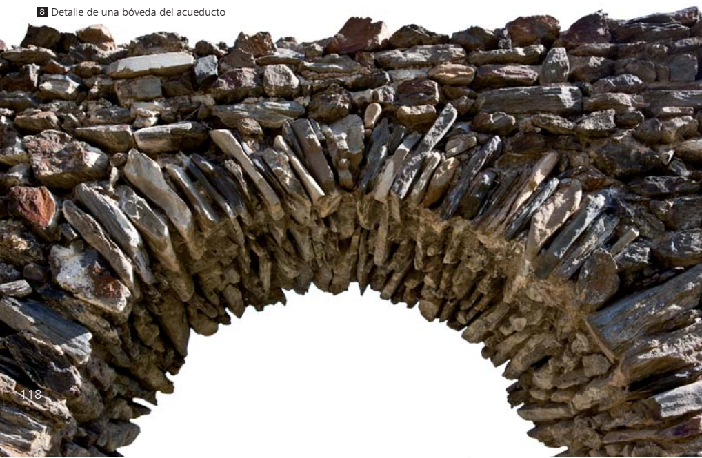
8 Detalle de una bóveda del acueducto
