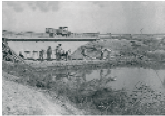
Construcción de caminos para el «ferrocarril» de la Compañía Marismas del Guadalquivir, 1927-1930. Colección González Arteaga.
