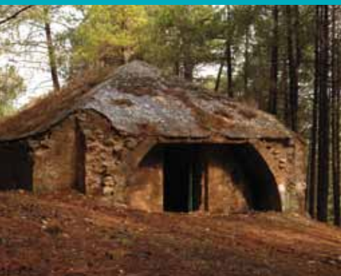
Edificio que alberga el pozo de nieve de la Canalica
