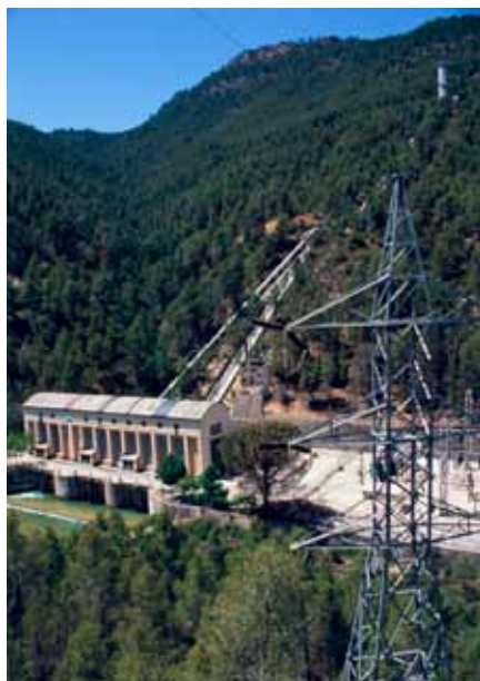
Largas tuberías alimentan la central hidroeléctrica
