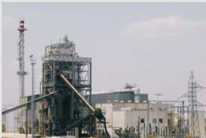
Planta energética de La Loma S.A. (Villanueva del Arzobispo, Jaén)
