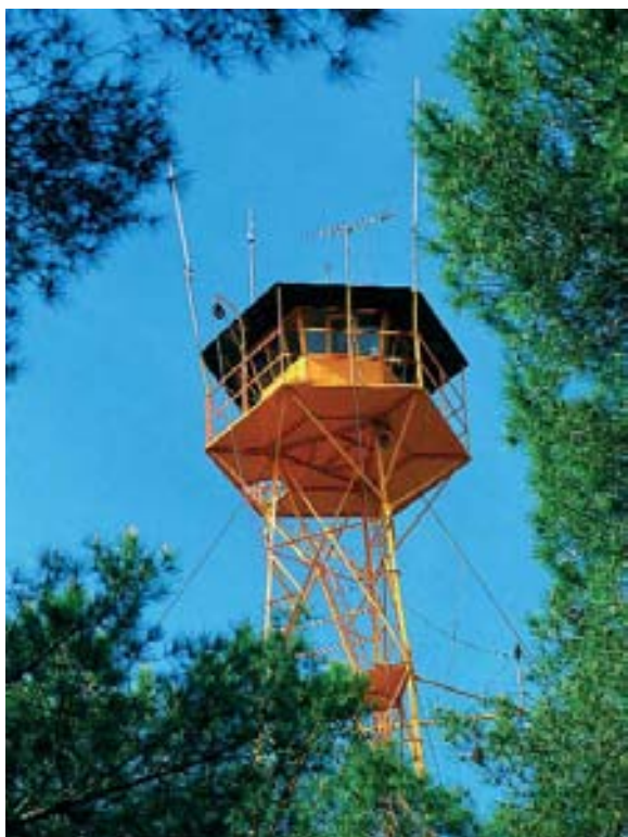
Torre de vigilancia
