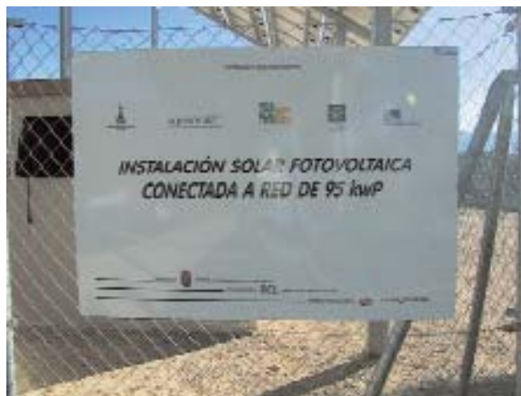
Instalación solar en Carchalejo, Sierra Mágina
